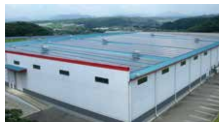
西日本ロジスティクスセンターの屋根スペースと 遊休部を活用した太陽光発電
