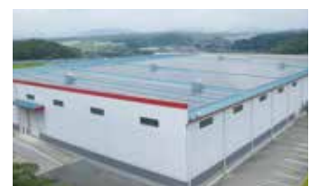
太陽光発電設備
