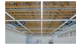
オートボックス四国中央店 本棟天井
